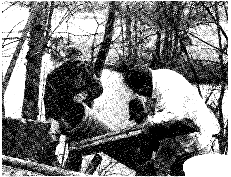
Bau der Eisvogelwand in Beuerberg
